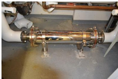
Figure 5: Catalyseur Mag-O-Pure d'une capacité de traitement anticalcaire jusqu'à 300 gpm.
