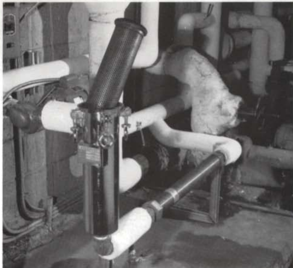
Les filtres retiennent les minéraux et les impuretés en suspension dans l'eau. Les filtres sont faciles à remplacer.
